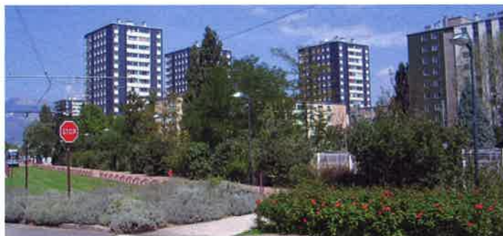
Le prix de la SDH récompense la réhabilitation thermique de 642 logements, dans le cadre du PRU au Village 2 d'Echirolles : passage de 215 kWh/m 2 /an à 75/80 kWh.
